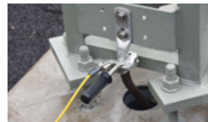
Erdverbindung an Erdungs- oder Kugelfestpunkt mit Universalklemme (TT 36UK)
