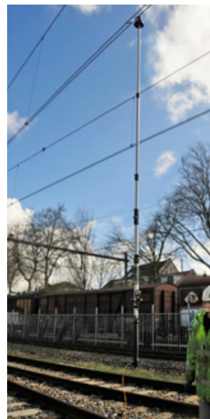
Prüfung an einer Bahn oberleitung
