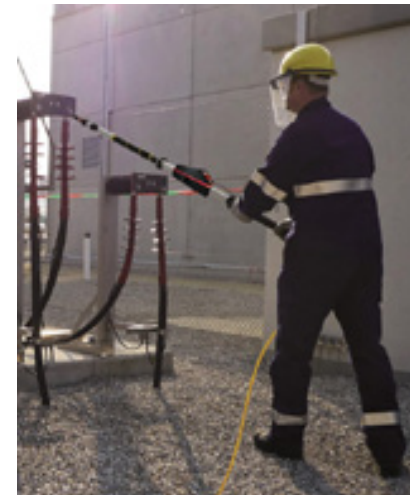
Prüfung mit HS 36 im 36 kV-Verteilerfeld
